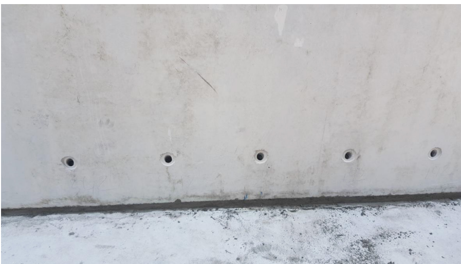
แผ่นพรีคาสที่ติดตั้งเรียบร้อยแล้ว
