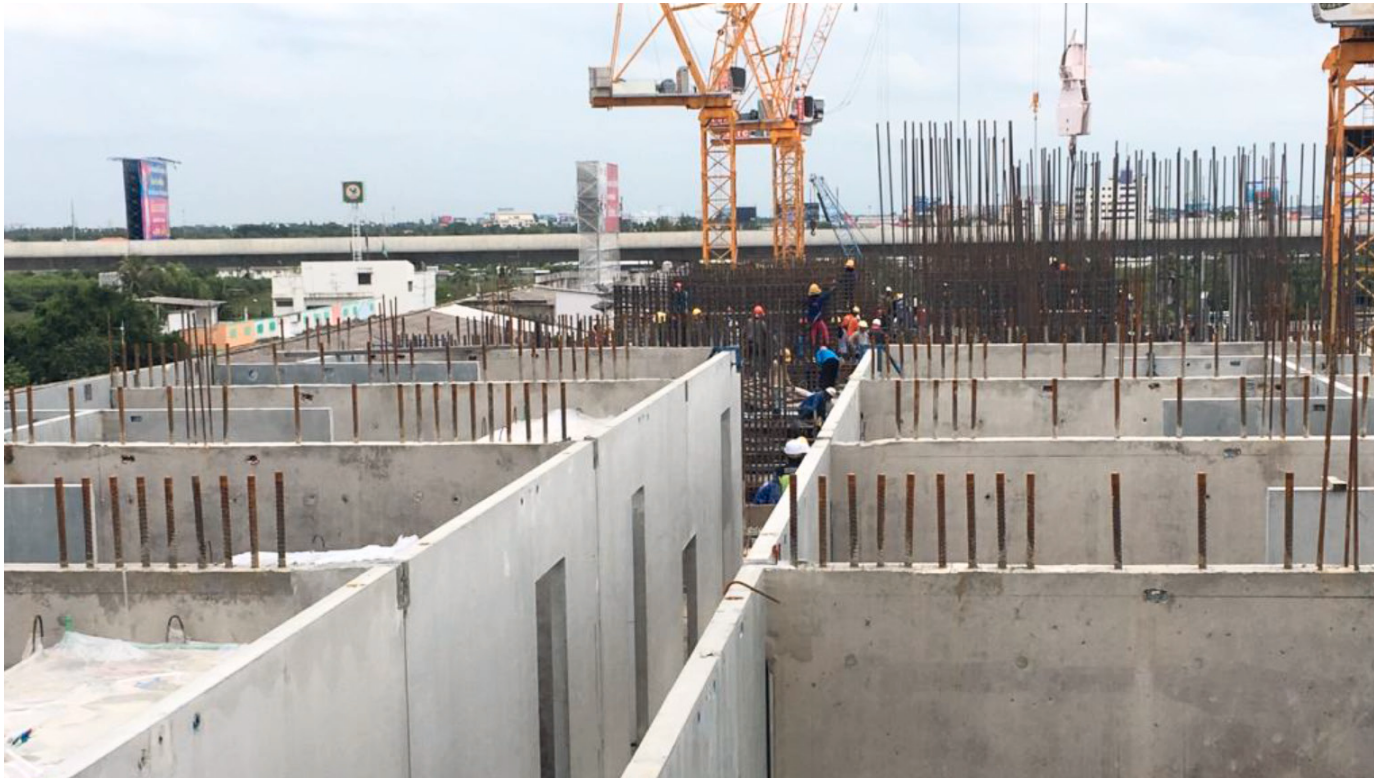
ระบบการก่อสร้างบ้านและอาคารสูง โดยใช้แผ่นพรีคาส
