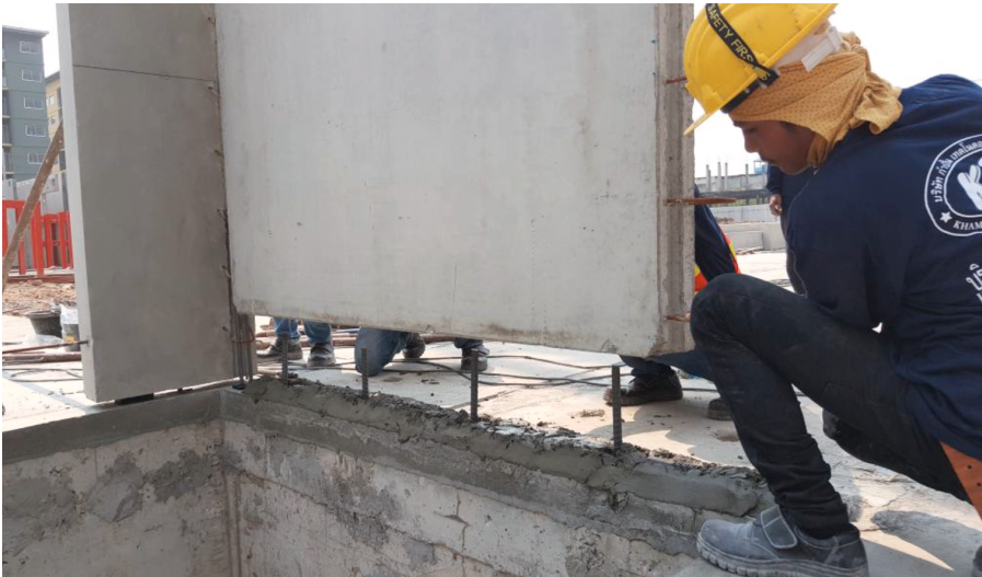
การตั้งแผ่นพรีคาสโดยใช้ เช็ทตั้ง มอริตารี
