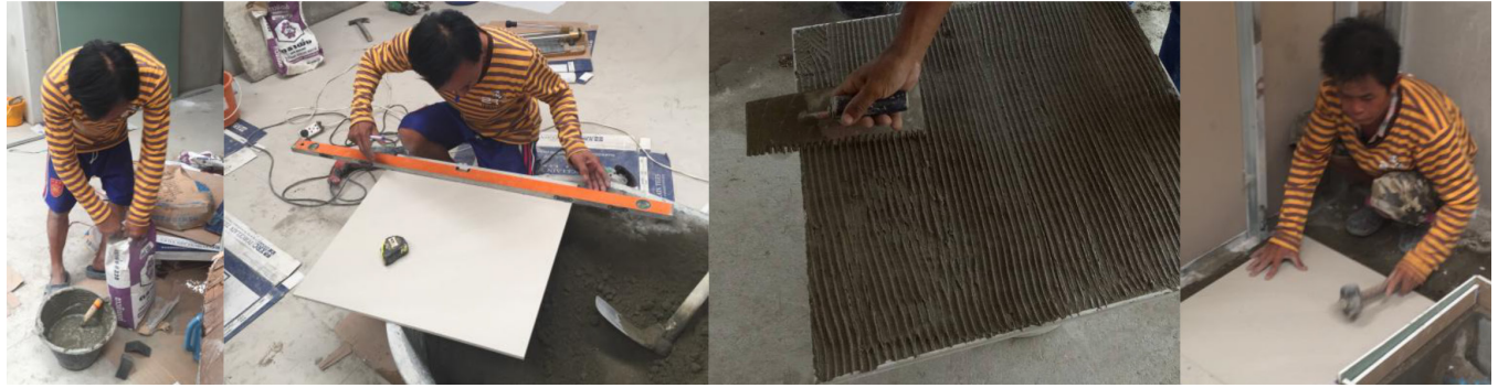
ภาพที่ 3 ขั้นตอนการปูกระเบื้อง
